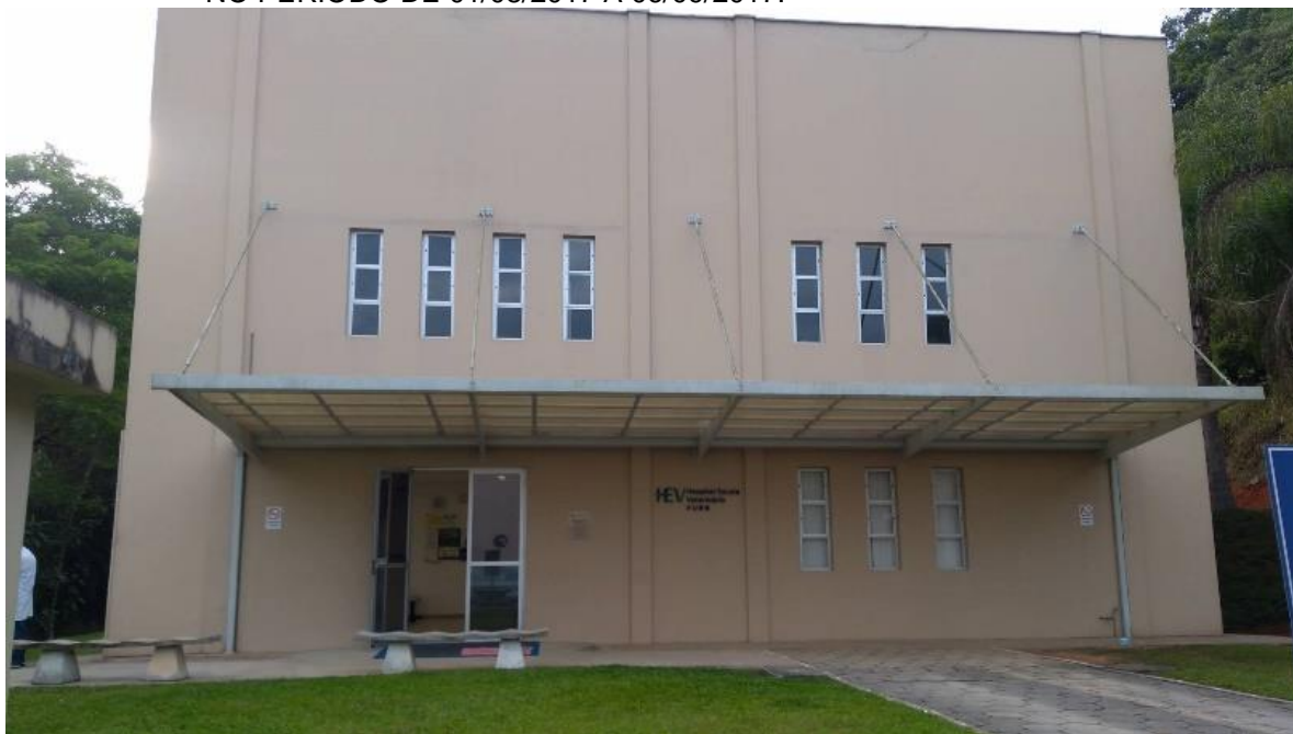
FIGURA 1 - VISTA DA FACHADA DO HOSPITAL ESCOLA VETERINÁRIO DA FACULDADE REGIONAL DE BLUMENAU, ONDE FOI REALIZADO O ESTÁGIO SUPERVISIONADO NO PERÍODO DE 01/08/2017 A 06/09/2017.
