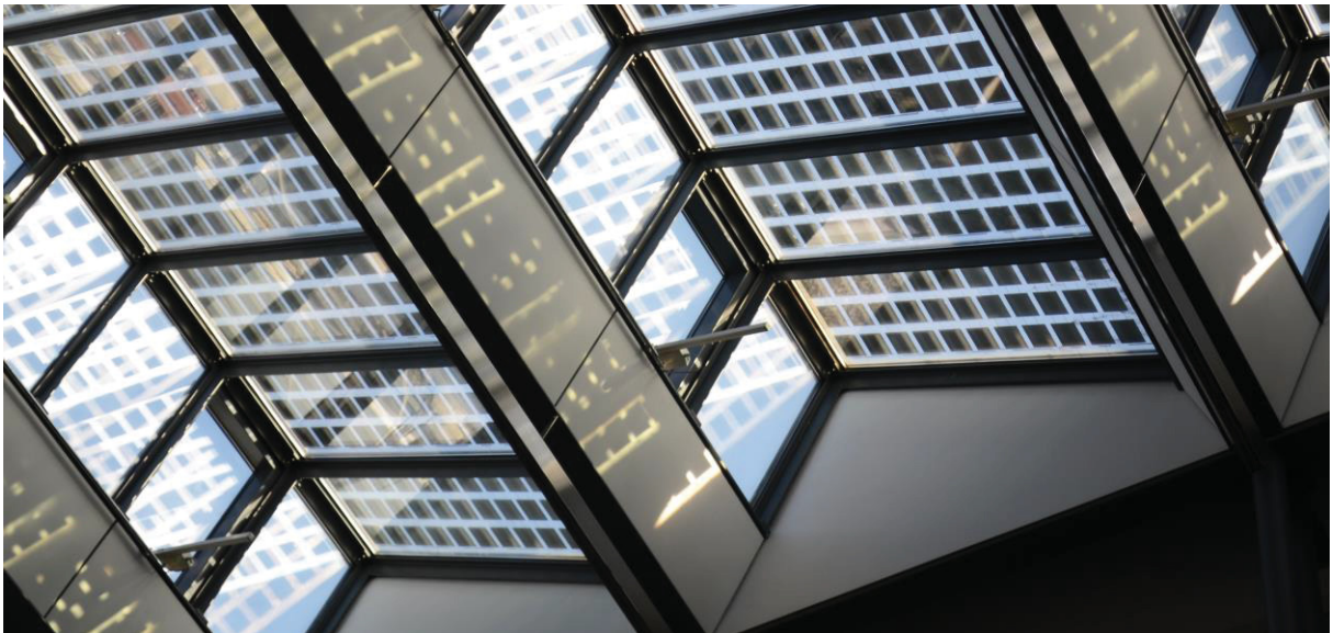
FIGURA 14 - COBERTURA SOBRE O REFEITÓRIO DO FRAUNHOFER INSTITUTE ISE
