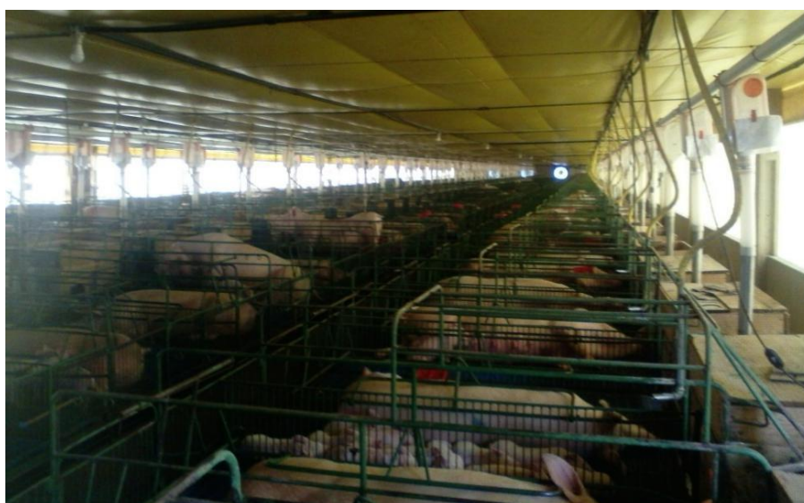
FIGURA 06 – Vista interna maternidade.
