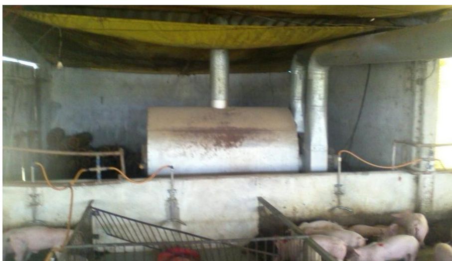
FIGURA 10 – Forno utilizado para aquecimento de creche.
