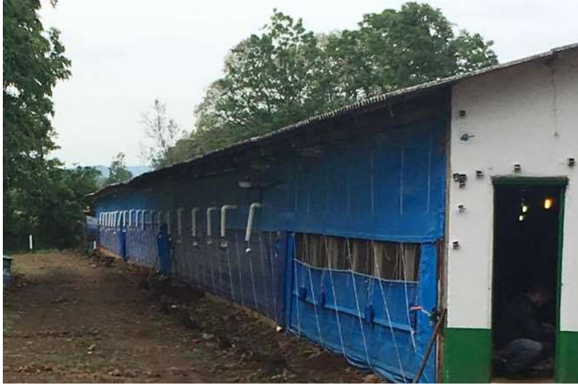
FIGURA 2 - AVIÁRIO SEMI CLIMATIZADO
