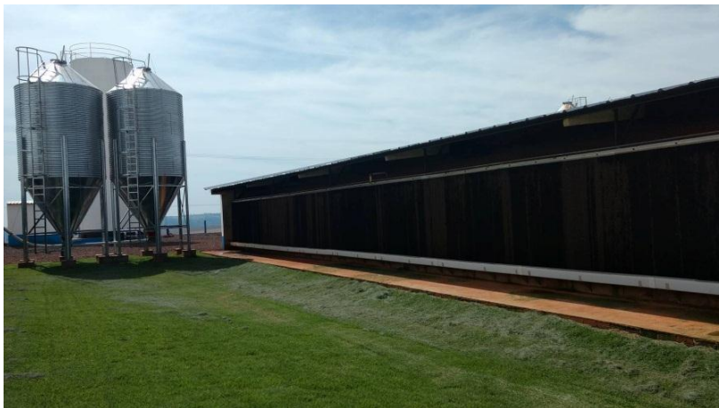
Figura 24 - Placa de resfriamento evaporativo.
