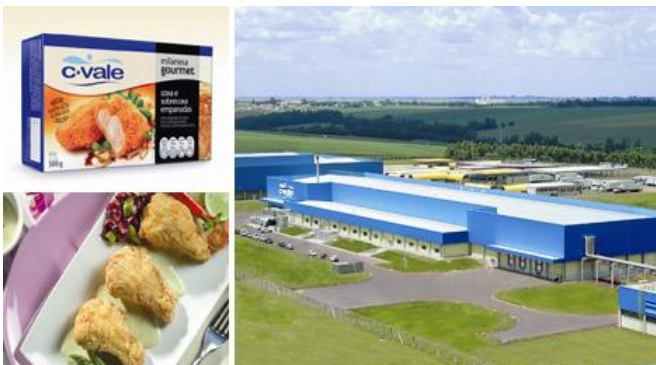
Figura 6 - Indústria de termoprocessados da C.Vale.
