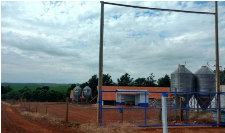
Figura 40 - Perímetro do aviário delimitado por cerca.
