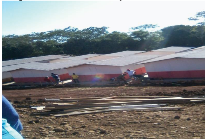
Figura 5: Finalizando a construção das salas de aulas
