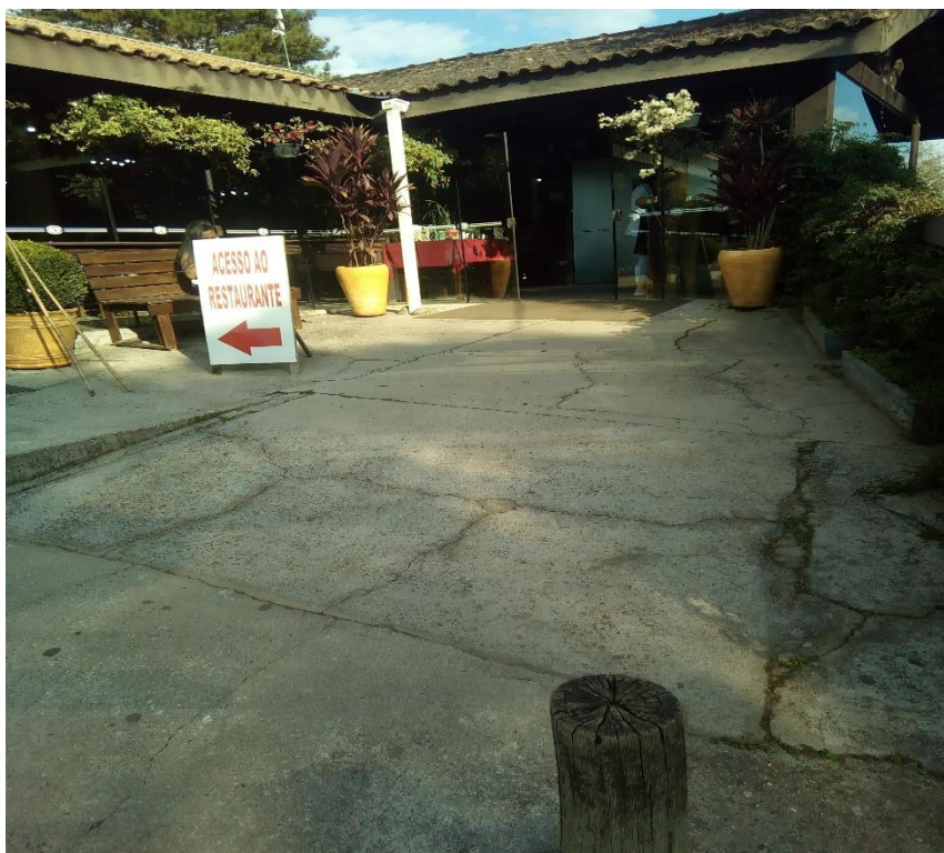
FIGURA 8 – ENTRADA DO SALÃO PRINCIPAL DA CHACARÁ EVÍSSIMA
