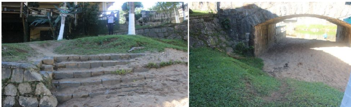
FIGURA 9 - ACESSO DE SAÍDA DA ATIVIDADE NO CENTRO HISTÓRICO DE MORRETES
