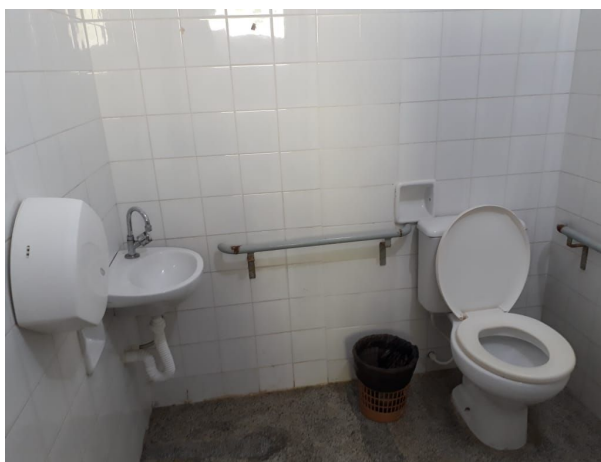
FIGURA 19 - ÁREA INTERNA DO BANHEIRO ACESSÍVEL FEM
