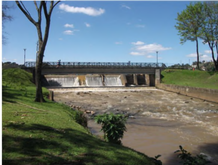
FIGURA 24 - QUEDA D'ÁGUA NA PONTE RIO BARIGUI
