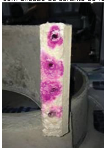
Figura 7 – Superfície de fissuras com difusão de corante de rodamina em torno dos tubos ocultos.
