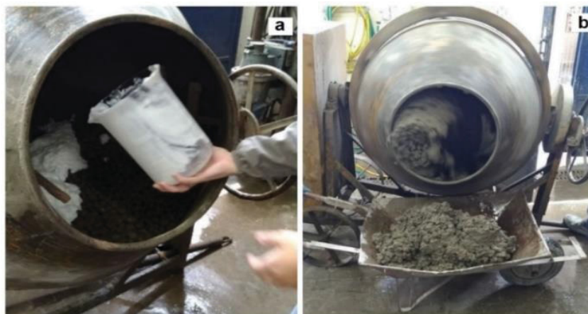
Figura 20 - a) Adição dos LDHs de nitrito em concreto, teor de 6%; b) Aspecto final do concreto contendo 6% de LDHs de nitrito.
