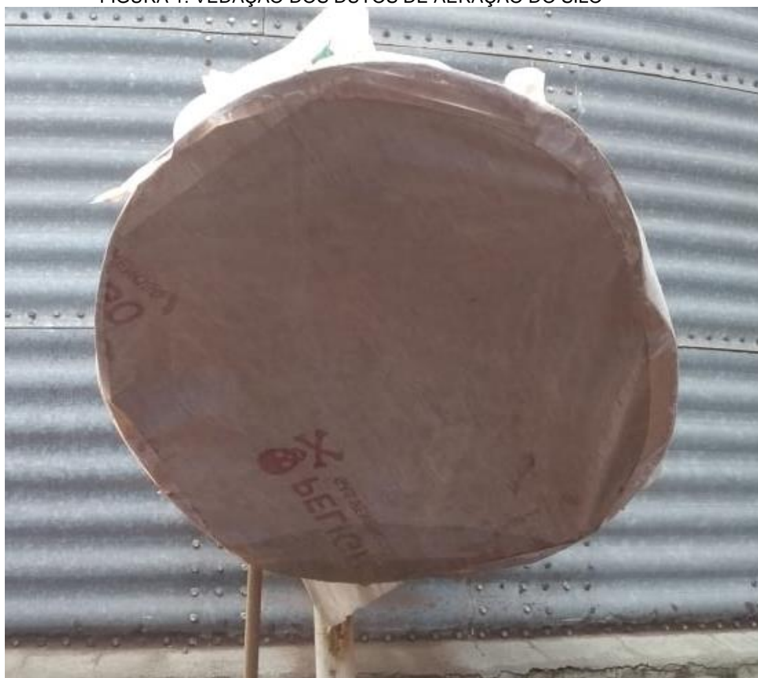
FIGURA 1: VEDAÇÃO DOS DUTOS DE AERAÇÃO DO SILO
