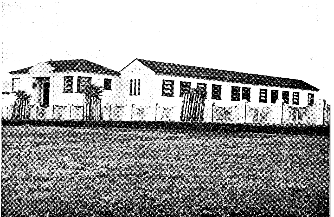
Conjunto do prédio principal
