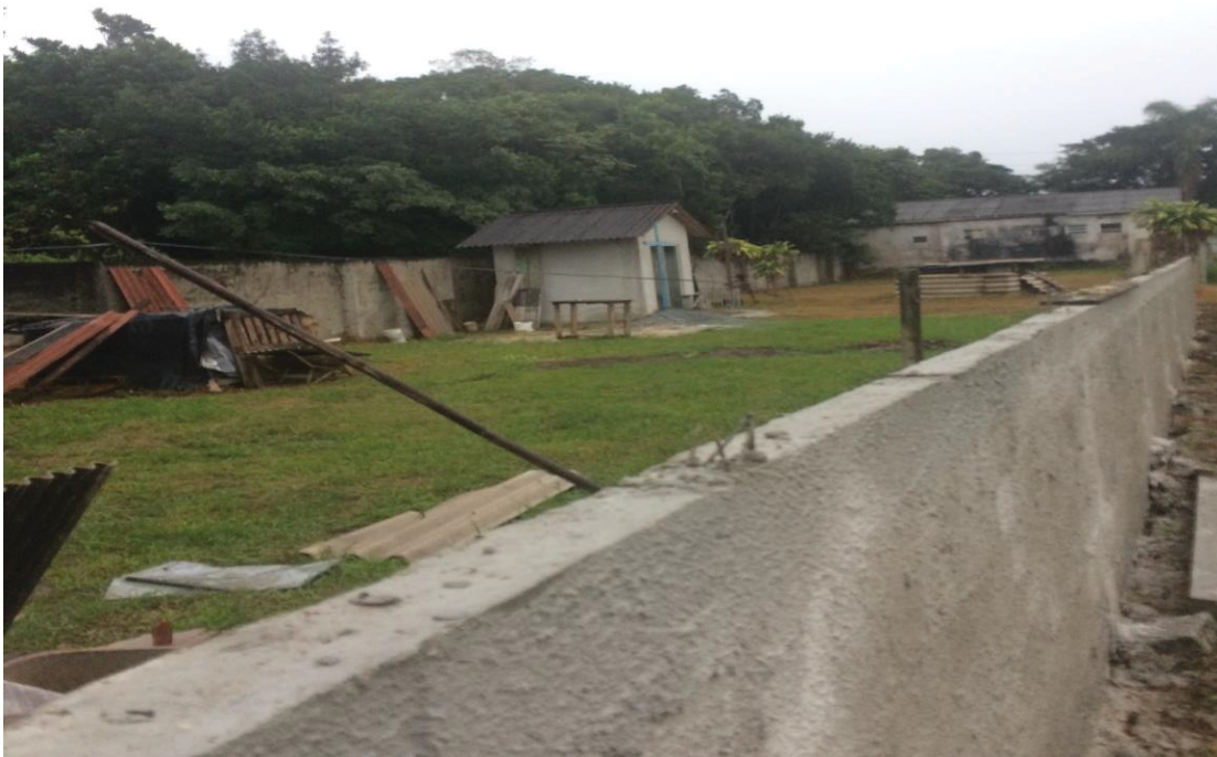
Foto 17: Terreno onde será construída a igreja. Foto: João Portes, 28/05/2019.
