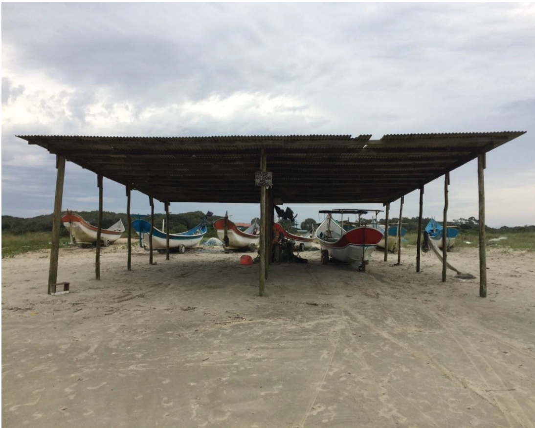
Foto 10: Barracão Canoas. Foto: João Portes, 28/05/2019.
