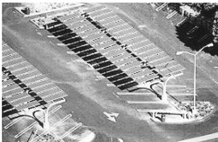
Figura 2 – Instalação de Painéis Fotovoltaicos em Estacionamento de Universidade.
