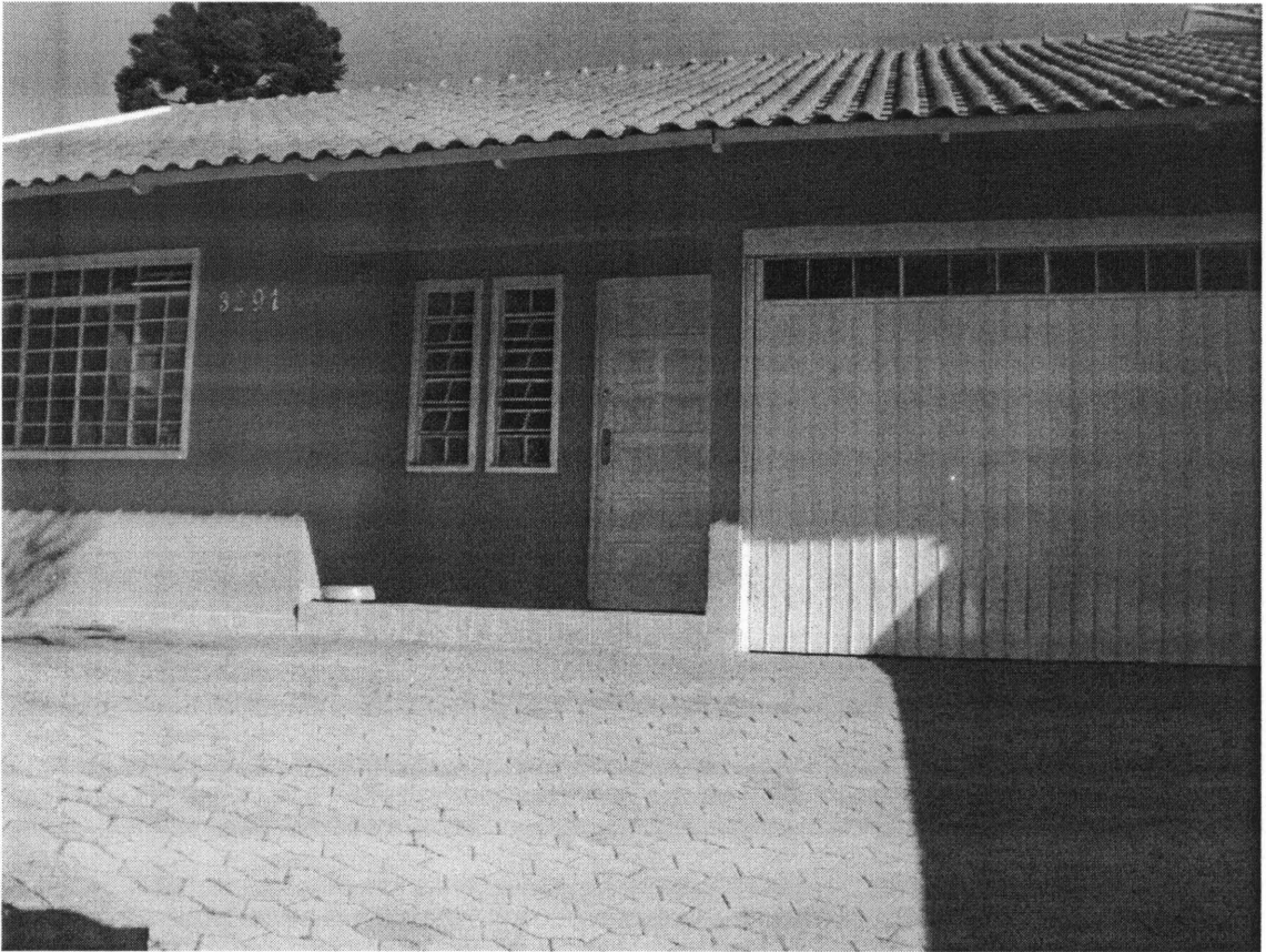
FIGURA 1 – FACHADA DO IMÓVEL.
