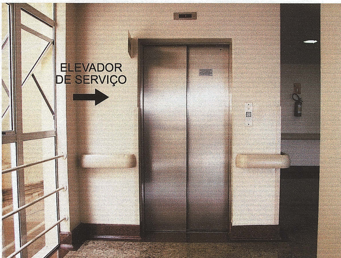
FOTOGRAFIA 9 – REGULAMENTAÇÃO DO USO DE ELEVADORES HPM/PR ELEVADOR DE SERVIÇO
