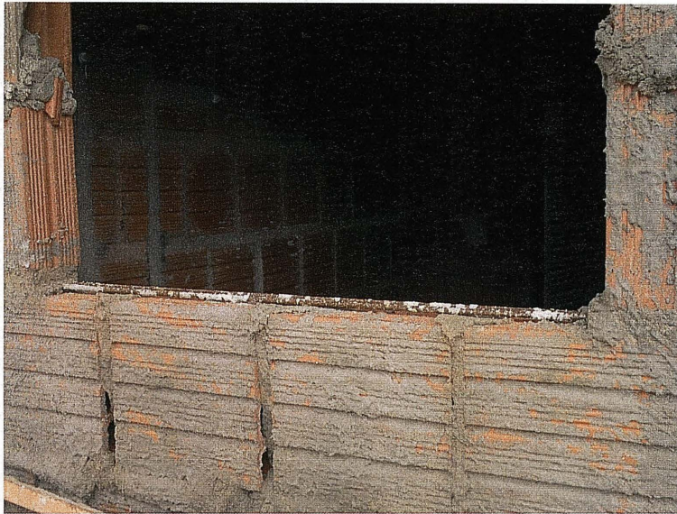
Figura 10- Colocação de dois ferros a substituindo a contra verga
