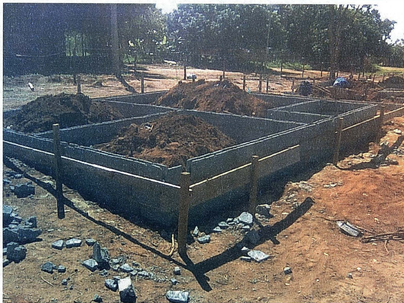
Figura 12- Quebra de blocos durante a execução dos
