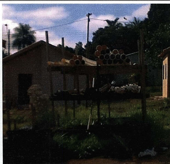
Figura 6- tubos sem proteção contra as intempéries.
