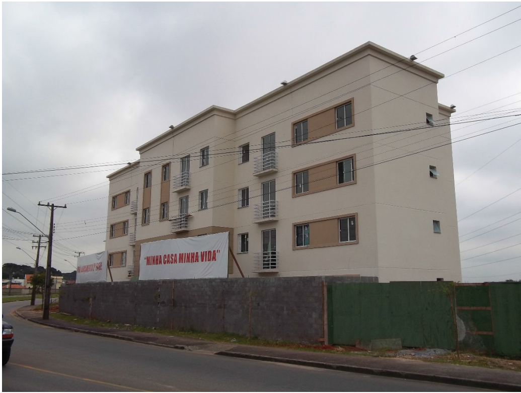
Figura 17 – Condomínio “Parques do Iguaçu” em construção (2011)
