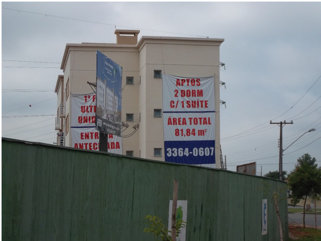
Figura 18 – Condomínio “Parques Iguaçu” em construção (2011)
