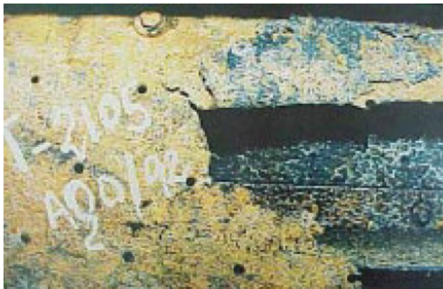
FIGURA 3: TORRE DE DESTILAÇÃO A VÁCUO – DETALHE DA BANDEJA
