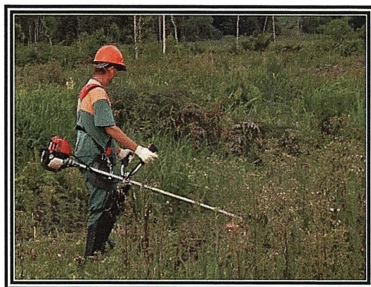
FIGURA 2 - ROÇADA DE MANUTENÇÃO MECANIZADA
