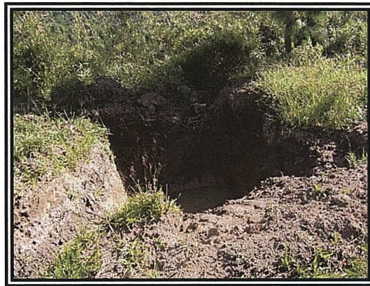
FIGURA 28 – CAIXAS DE CONTENÇÃO E VALAS DE DRENAGEM
