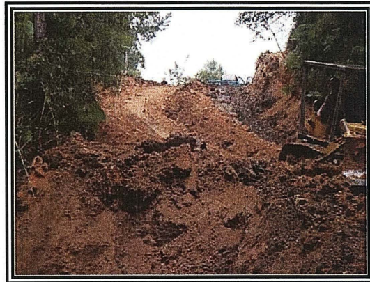
FIGURA 25 – CONSTRUÇÃO DE ESTRADAS
