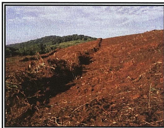
FIGURA 14 – ENLEIRAMENTO COM LÂMINA FLECO
