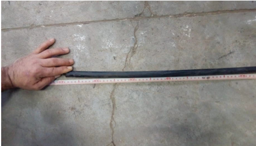
FIGURA 4.3 - MEDIÇÃO DO COMPRIMENTO DOS CABOS
