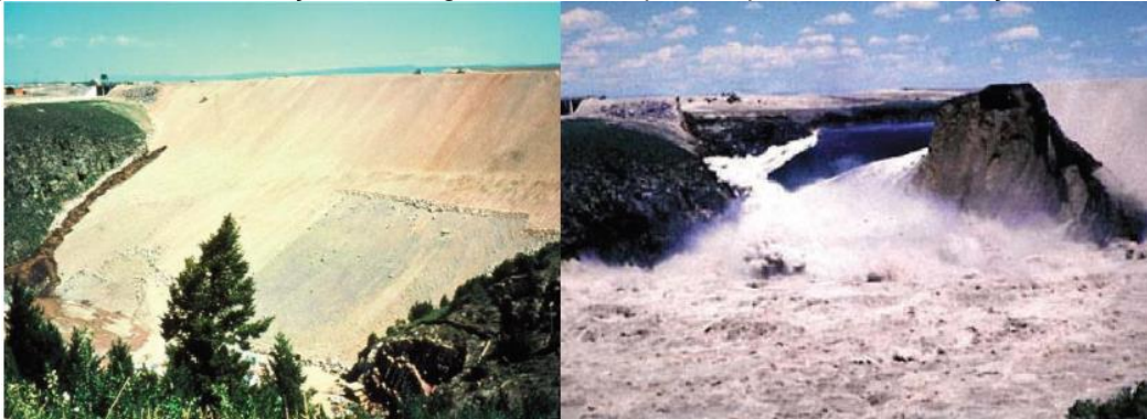
Figura 20 - Vista do maciço da barragem antes e depois do processo de formação da brecha.
