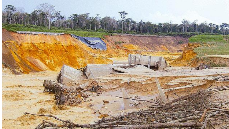
Figura 22 – Danos causados pela ruptura da Barragem de Apertadinho.
