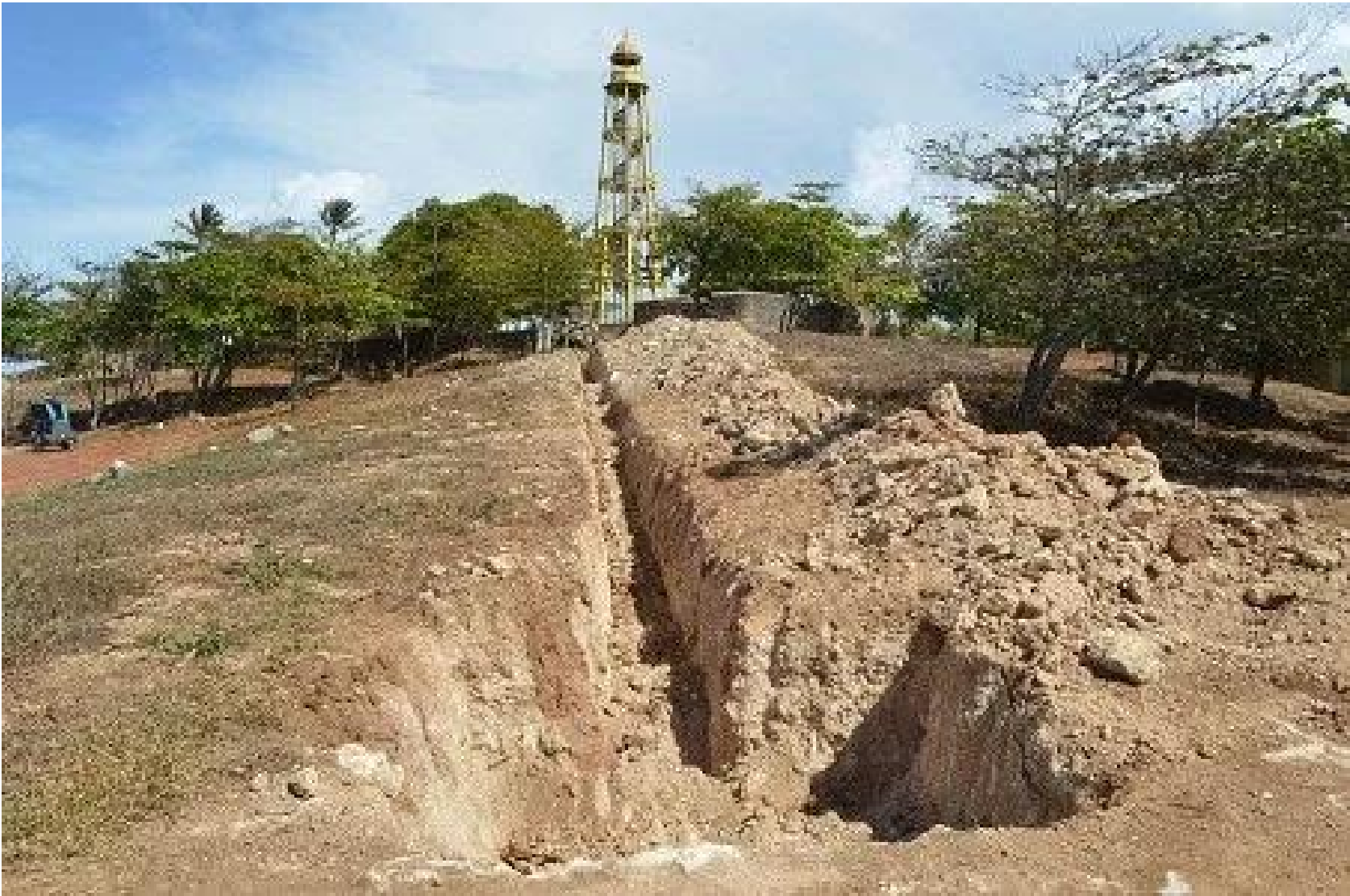
FIGURA A 4.4 – OBRAS PUNTILLA FORTALEZA DE SAN FELIPE DE PUERTO PLATA
