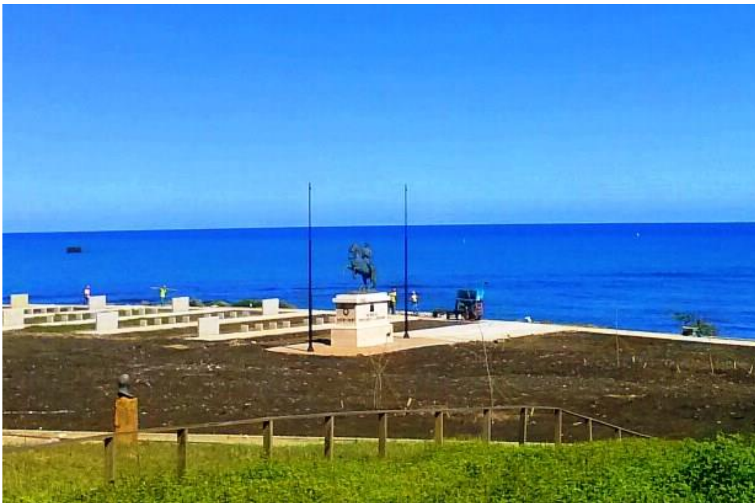
FIGURA A 4.8 – CONCLUSÃO OBRAS PUNTILLA FORTALEZA DE SAN FELIPE DE PUERTO PLATA
