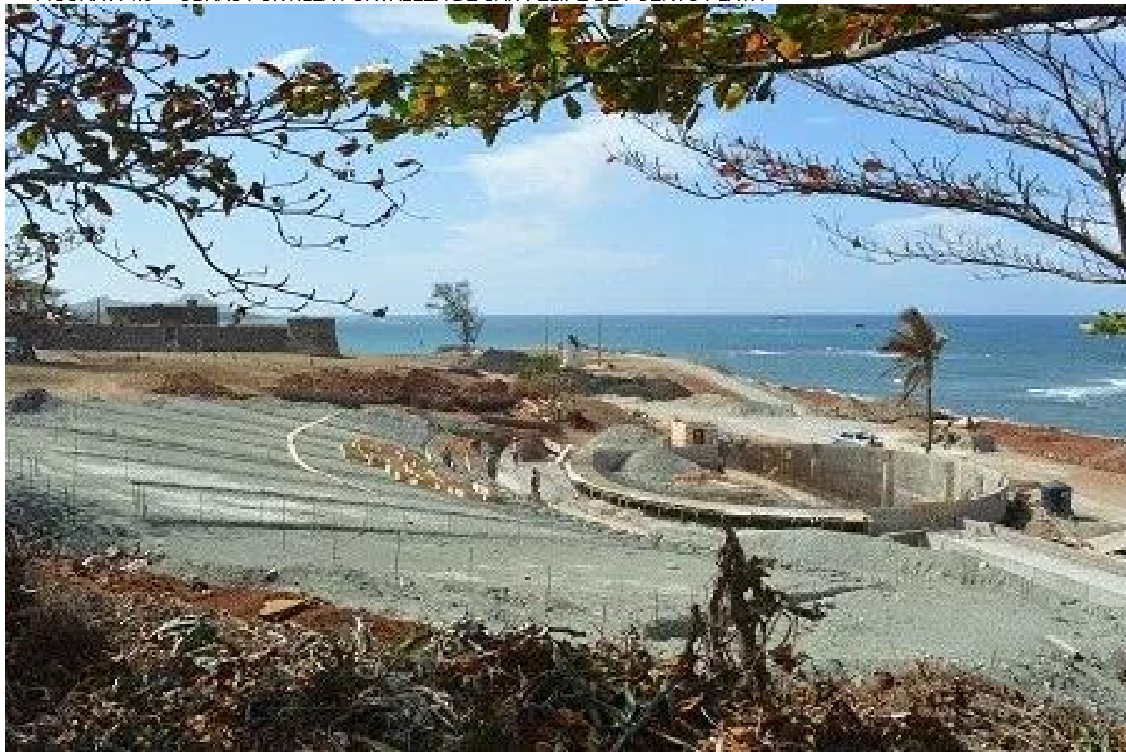
FIGURA A 4.6 – OBRAS PUNTILLA FORTALEZA DE SAN FELIPE DE PUERTO PLATA
