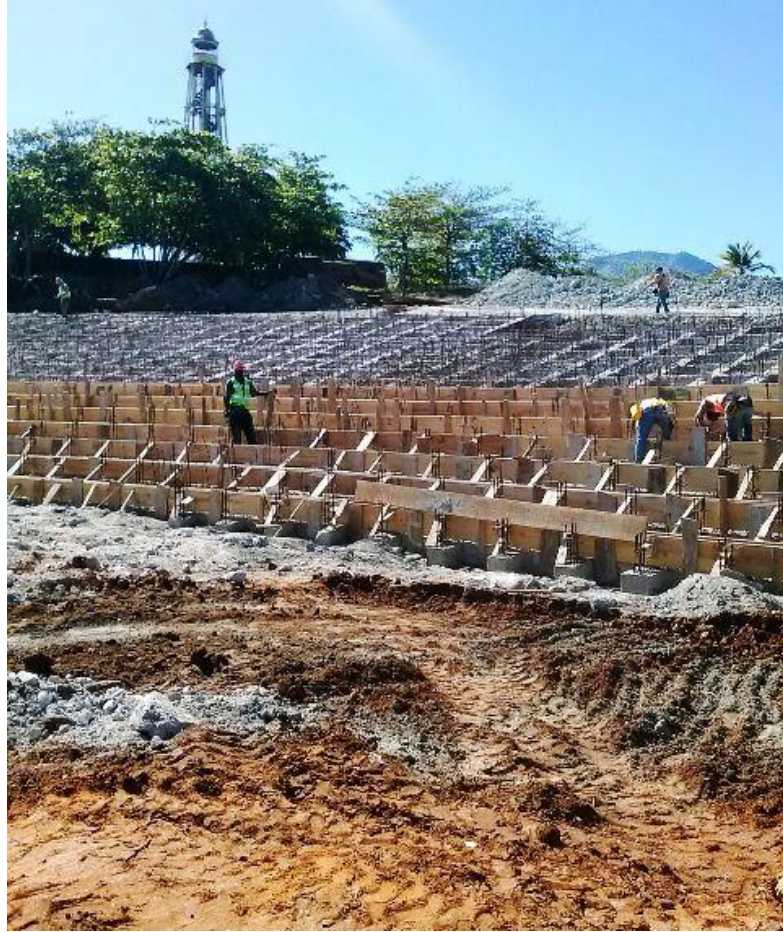
FIGURA A 4.3 – OBRAS PUNTILLA FORTALEZA DE SAN FELIPE DE PUERTO PLATA
