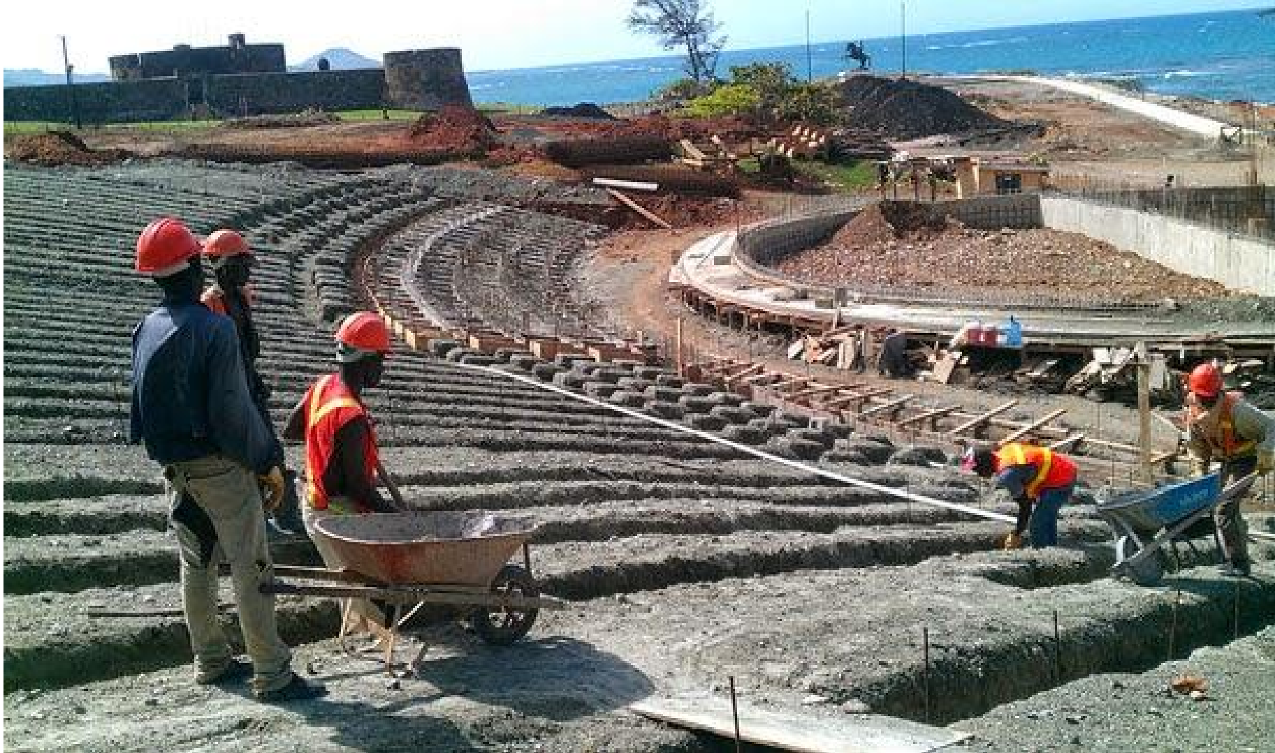
FIGURA A 4.5 – OBRAS PUNTILLA FORTALEZA DE SAN FELIPE DE PUERTO PLATA
