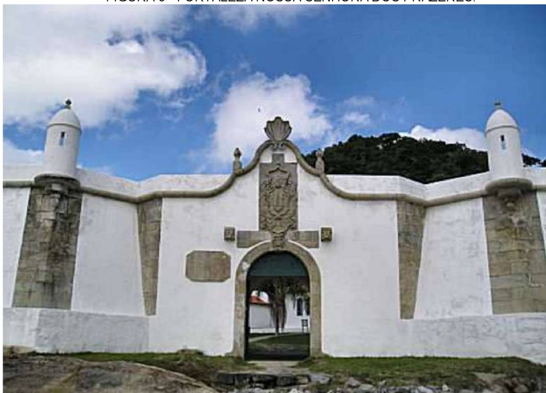
FIGURA 3 - FORTALEZA NOSSA SENHORA DOS PRAZERES.
