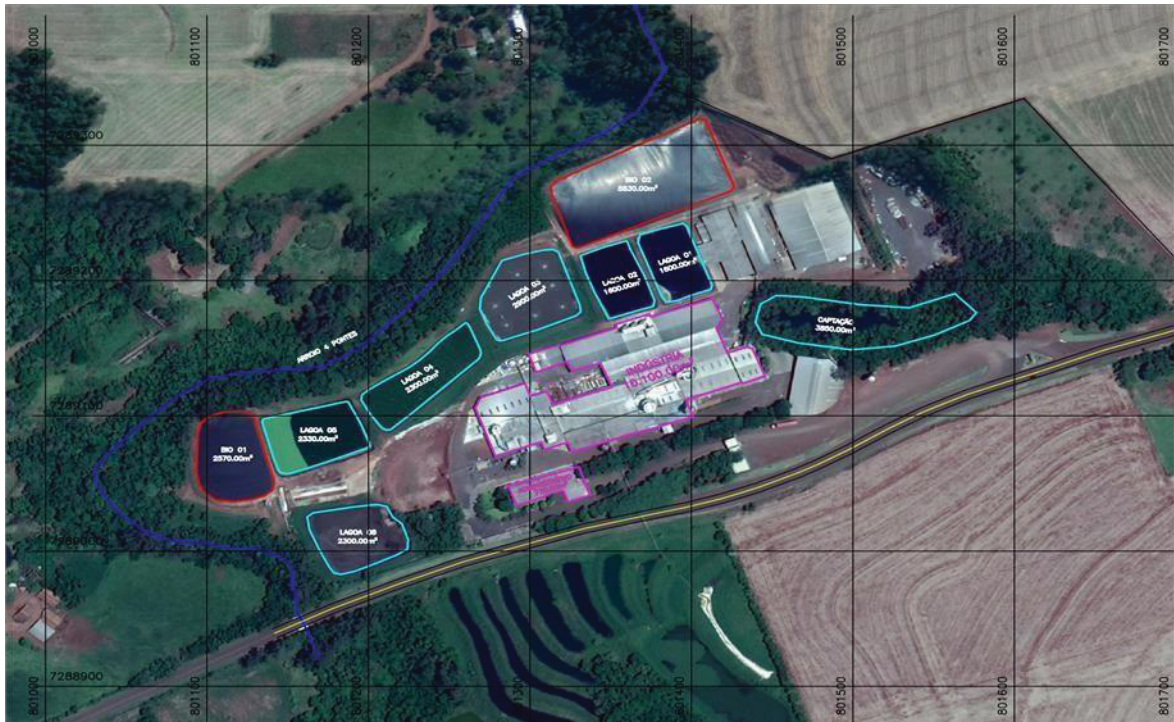
FIGURA 8 – IMAGEM DO SISTEMA DE TRATAMENTO DE EFLUENTES DA FECULARIA HORIZONTE
