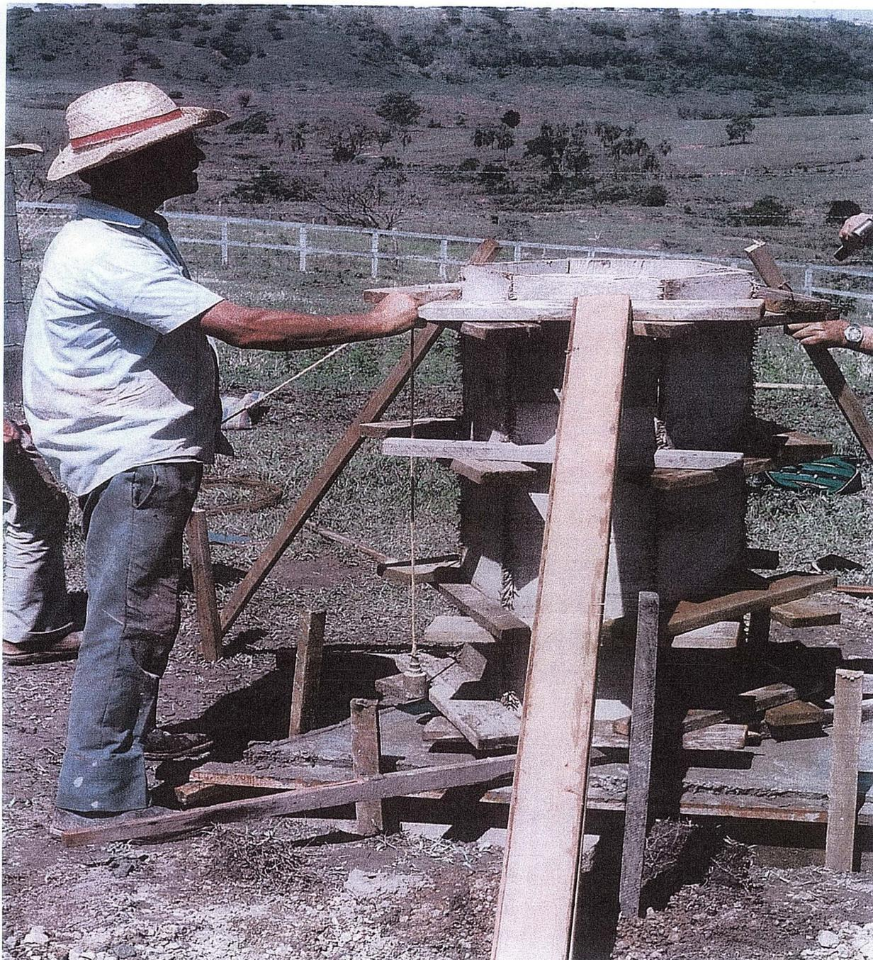
Colocação da forma do pilar, nivelada com prumo de pedreiro e escorada com ripas para não cederem quando da colocação do concreto.
