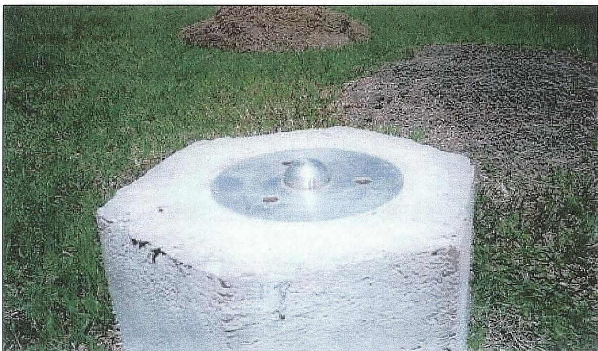
Figura 42 - Dispositivo de Centragem forçada padrão UFPR fechado.
