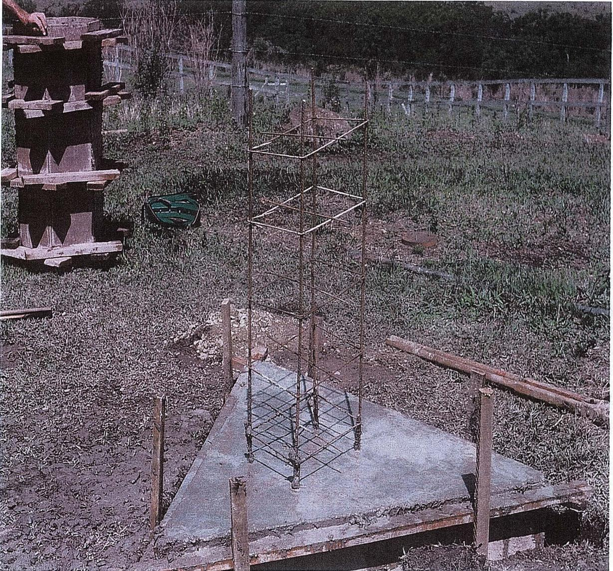
A base já concretada, com os ferros do pilar amarrados com arame recozido nos ferros de espera.
