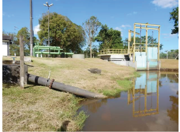
FIGURA 7 – Ponto de coleta de água na captação da ETA Colônia (Pr01).
