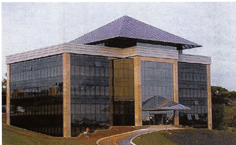
Figura 3.2 - Edifício Sede do LACTEC
