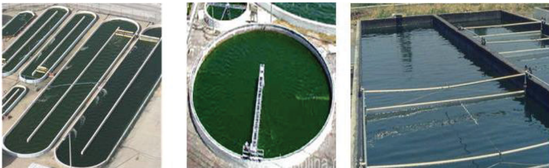
Figura 1: Sistemas abertos de cultivo de microalgas: lagoas tipo pista, lagoas circulares e tanques abertos, respectivamente.
