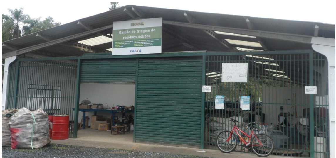
Figura 1: Galpão de triagem de resíduos sólidos (A autora, 2018)
