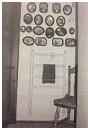
FIGURA 6 – ESCADA ACOPLADA À PAREDE PARA AUXILIAR EM CASO DE QUEDA
