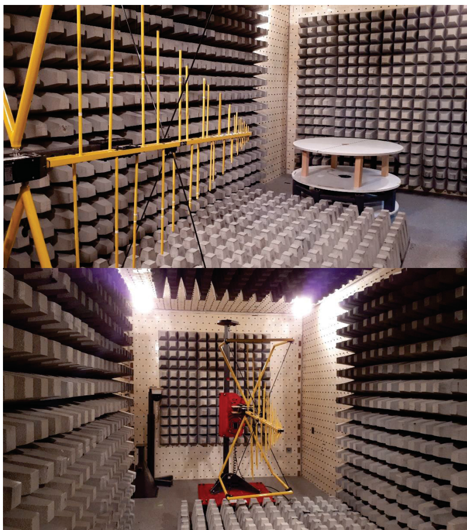
FIGURA 7 – FINALIZAÇÃO DA MONTAGEM - INTERNO (ABRIL/2018)
