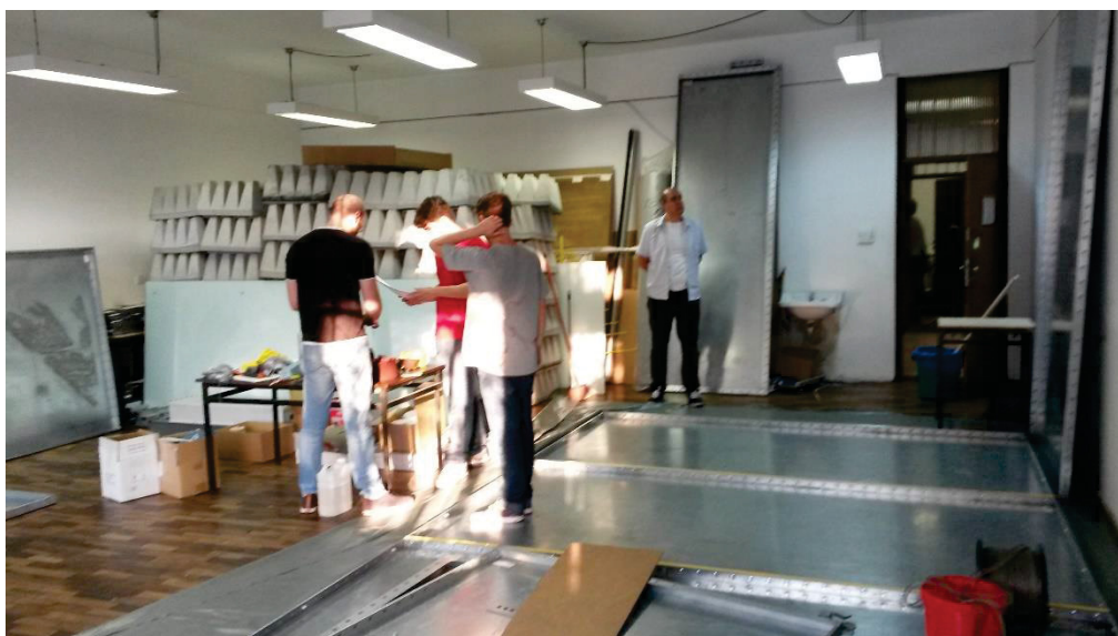
FIGURA 5 – INÍCIO DA MONTAGEM DO LABORATÓRIO (SET/2017)
