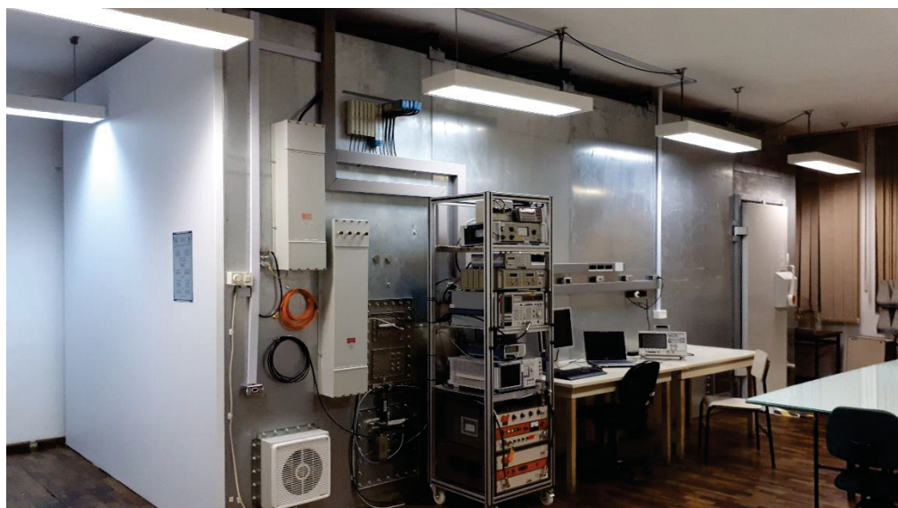
FIGURA 6 – FINALIZAÇÃO DA MONTAGEM - EXTERNO (ABRIL/2018)
