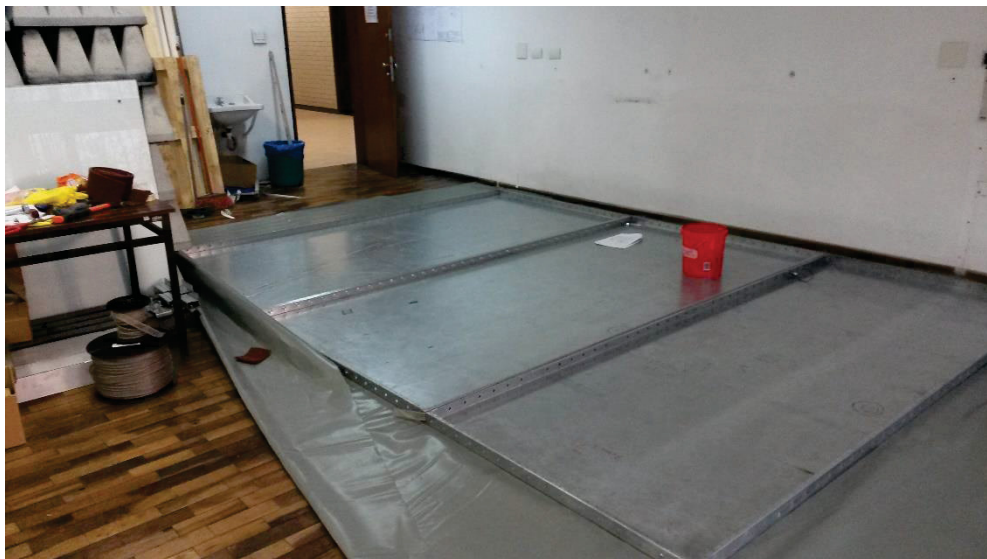
FIGURA 4 – INÍCIO DA MONTAGEM DO LABORATÓRIO (SET/2017)
