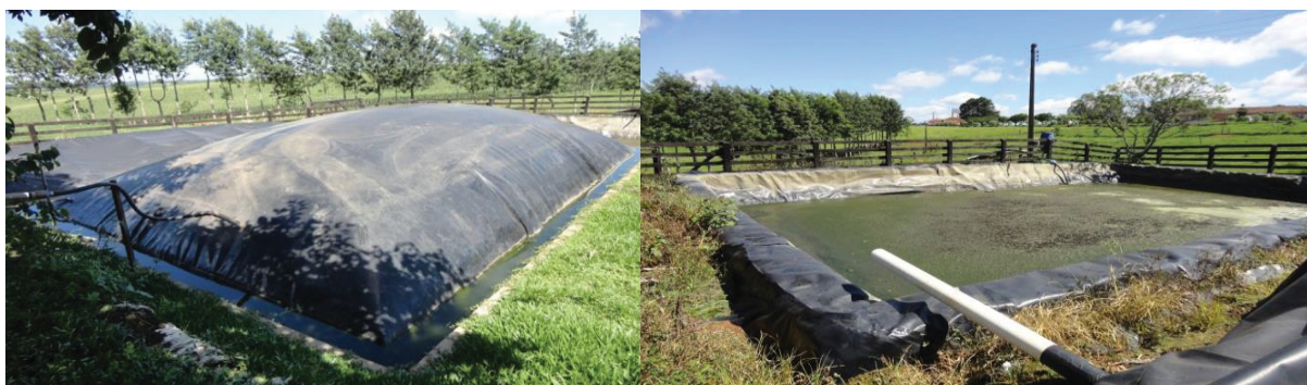
FIGURA 08 – BIODIGESTOR ANAERÓBICO DO CTP DE CASTROLANDA (CASTRO – PR)
