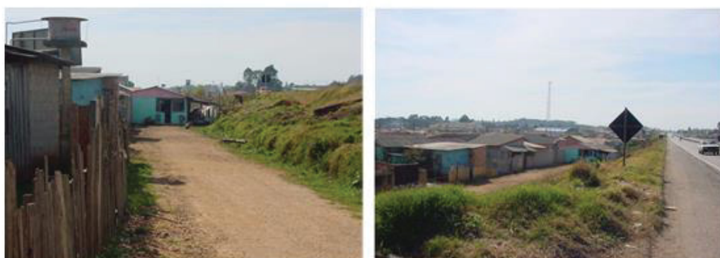
FIGURA 25: MORADIAS NA FAIXA DE ATINGIMENTO DA BR 116 NO JARDIM LIBERDADE - 2009
