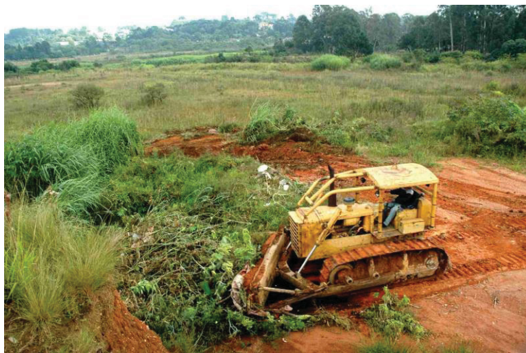
FIGURA 22: PREPARAÇÃO DO TERRENO PARA A INTERVENÇÃO NO JARDIM MARAMBAIA - 2010
