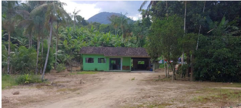
Nova residência (A8), construída após o deslizamento
