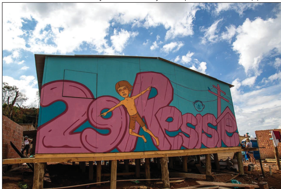
FIGURA 31. Reconstrução da 29 de Março com apoio da ONG TETO (2).
