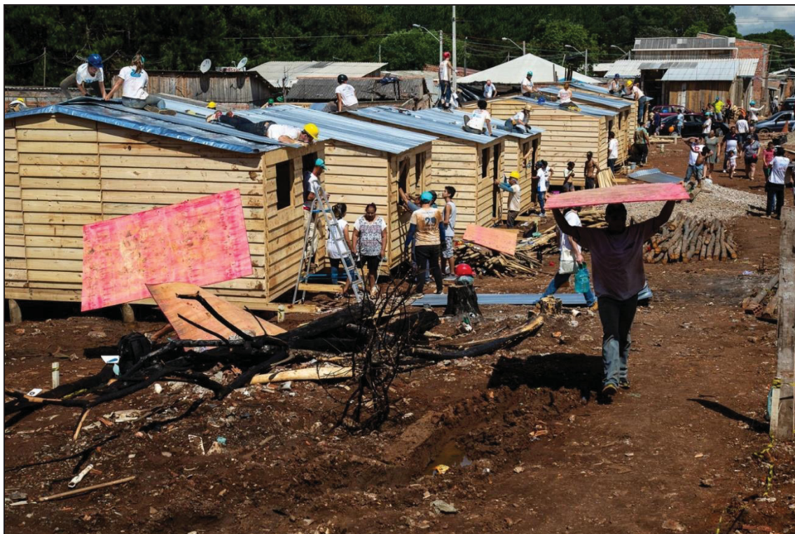
FIGURA 30. Reconstrução da 29 de Março com apoio da ONG TETO (1).
