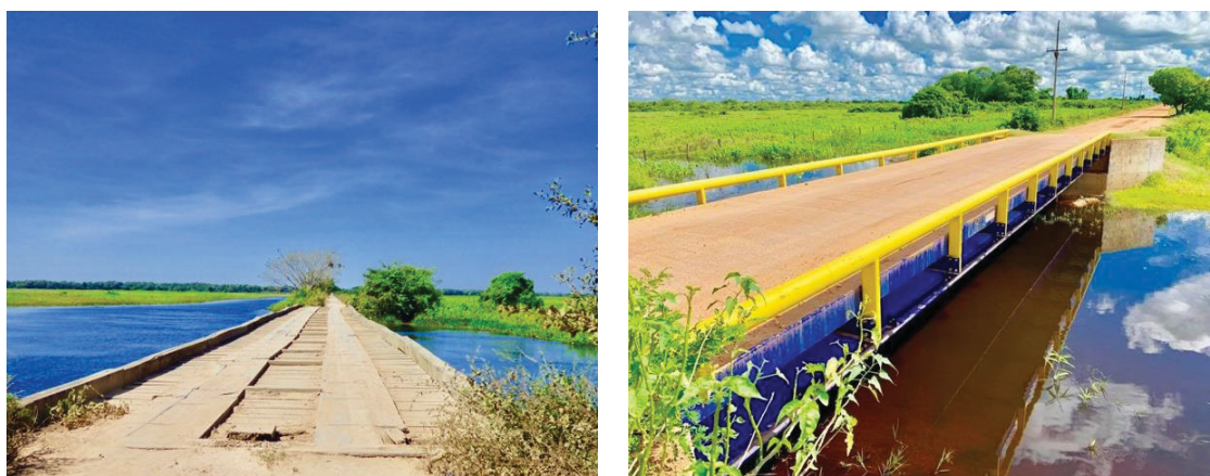
FIGURA 24 e FIGURA 25 – PONTES ORIGINAIS DE MADEIRA SENDO SUBSTITUÍDAS POR PONTES DE CONCRETO
