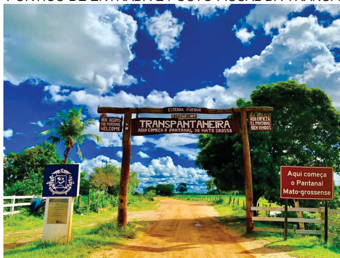
FIGURA 27 – PÓRTICO DE ENTRADA E POSTO FISCAL DA TRANSPANTANEIRA
