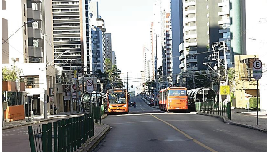
FIGURA 4 - CORREDOR DE ÔNIBUS BRT ( BUS RAPID TRANSIT ) NA CIDADE DE CURITIBA (AVENIDA SETE DE SETEMBRO)
