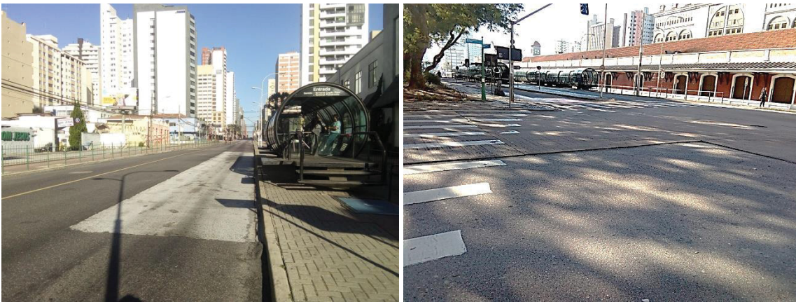
FIGURA 5 - PAVIMENTO RÍGIDO a) EM PARADA DE ÔNIBUS EM CURITIBA – AV. SETE DE SETEMBRO b) PRÓXIMO À INTERSEÇÕES DE CORREDORES DE ÔNIBUS BRT - CRUZAMENTO DA AV. SETE DE SETEMBRO COM A AV. MARECHAL FLORIANO PEIXOTO
