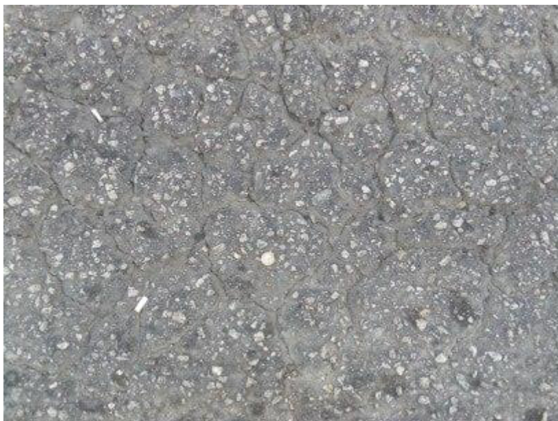
FIGURA 12 - TRINCA POR FADIGA EM REGIÃO PRÓXIMA A UM SEMÁFORO NA RUA MARECHAL DEODORO NA CIDADE DE CURITIBA
