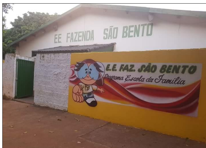
Foto 9 - Muro da Escola Recentemente
