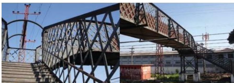
FIGURA 26 - PASSARELA DE FERRO FUNDIDO
