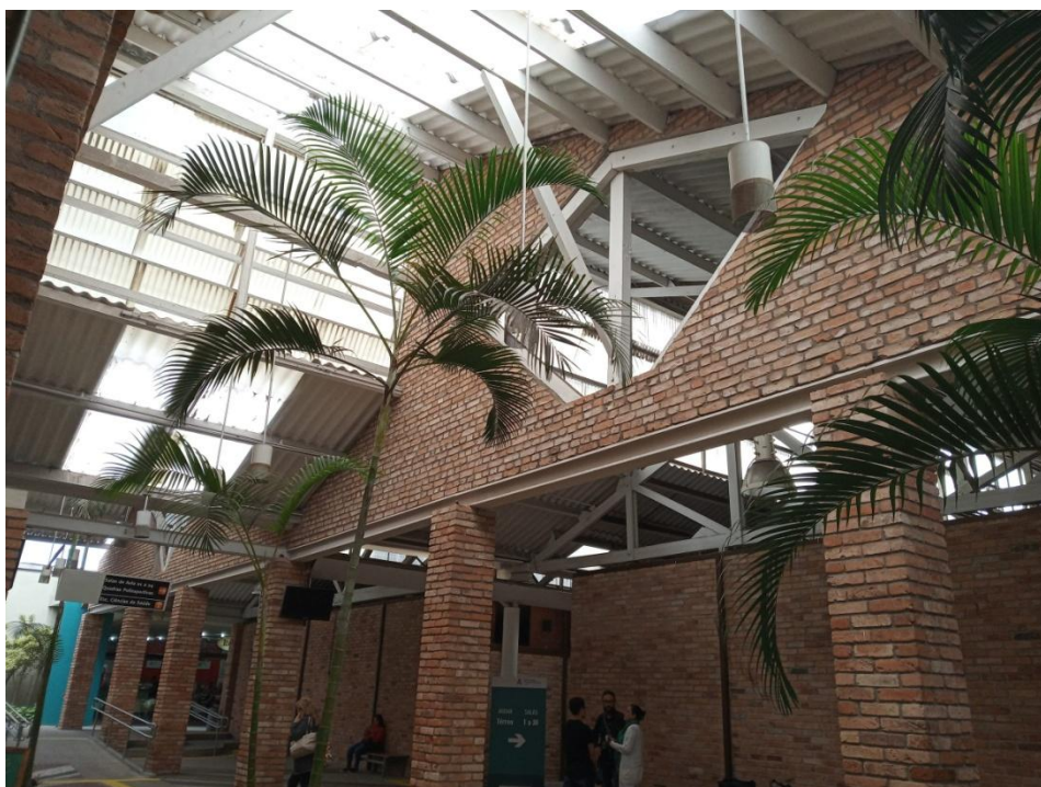
FIGURA 24 - DETALHE ESTRUTURA DO TELHADO
