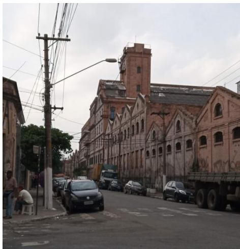
FIGURA 6 - VISTA LATERAL DO CONJUNTO PELA RUA MONSENHOR ANDRADE
