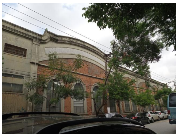
FIGURA 23 - DETALHE NA FACHADA
