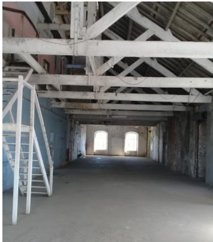
FIGURA 9 - ANDAR SUPERIOR DO PRÉDIO PRINCIPAL.
