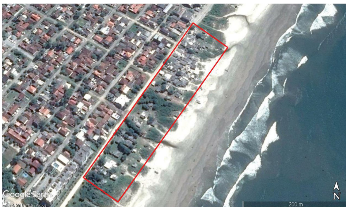
Figura 34: Mancha de ocupação irregular na orla do balneário Ipanema (delimitada em vermelho).
