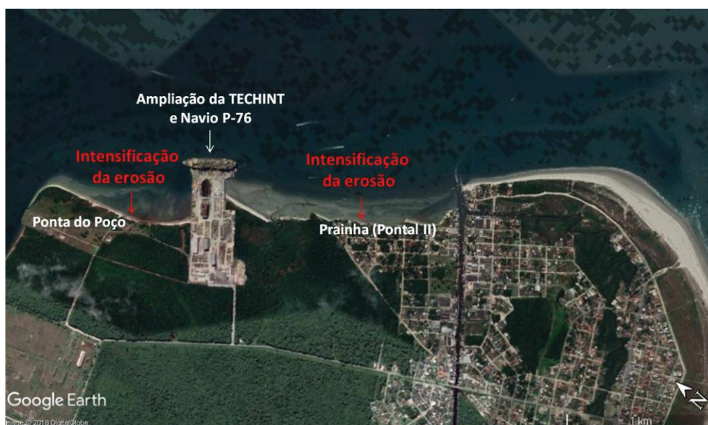
Figura 27: Novo cais da empresa Techint, Navio-plataforma P-76 e indicação dos locais da suposta intensificação dos processos erosivos da região em função da presença dessas estruturas. Fonte: Elaboração própria. Imagem de satélite: Google Earth (2018).
