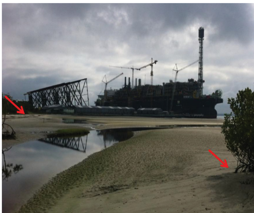
Figura 32: Vista panorâmica da região da foz do rio Penedo, nas adjacências da Techint. As setas vermelhas indicam elevações no terreno, evidenciando a retenção e deposição de sedimentos por influência das instalações da empresa. Fonte: Saída de campo (2017).
