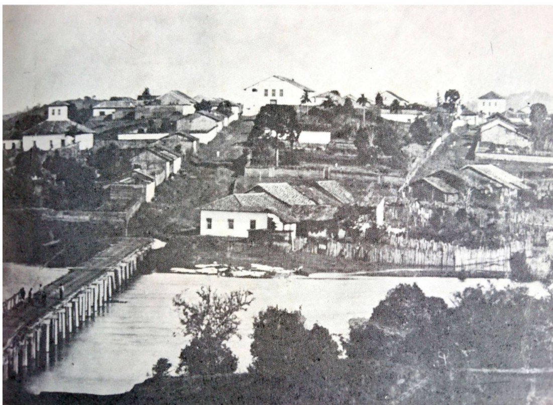
Igreja Matriz de Castro, sem torre, em 1876. Prédio da Câmara e Cadeia no canto superior direito. Abaixo, ponte sobre o rio Iapó. Cf. BORBA, 1986, foto 1.
