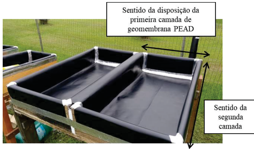
Figura 19 – Telhados com geomembrana PEAD instalada
