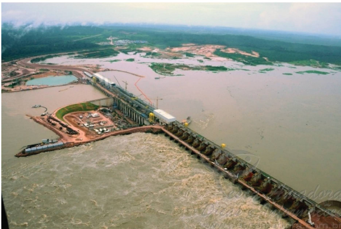
Figura 29 – Usina Hidrelétrica de Jirau (RO) (Fonte: (ENERCONS, 2017))
