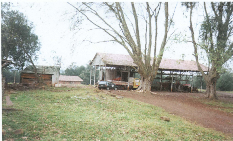
FIGURA 3: Barracão das Máquinas
