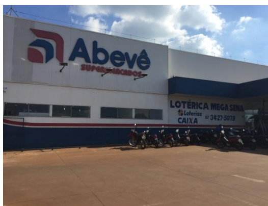
Figura 2 – Fachada de um dos estabelecimentos da rede ABEVÊ de supermercados na cidade de Dourados – MS. Fonte: A Autora, 2018.
