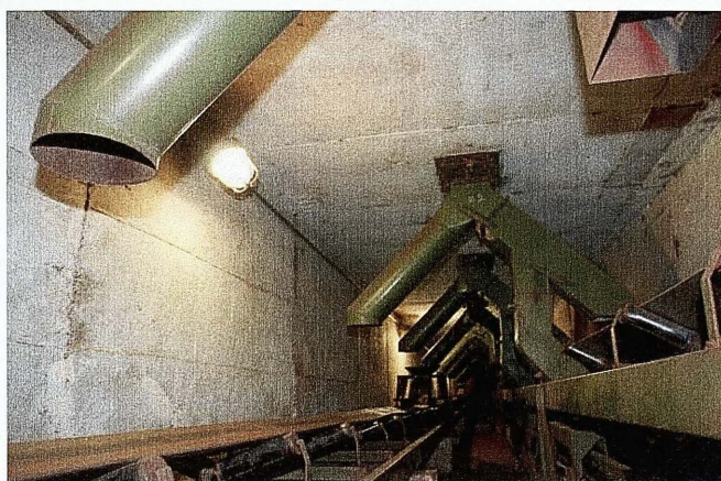
FIGURA 2 – Túnel da moega
