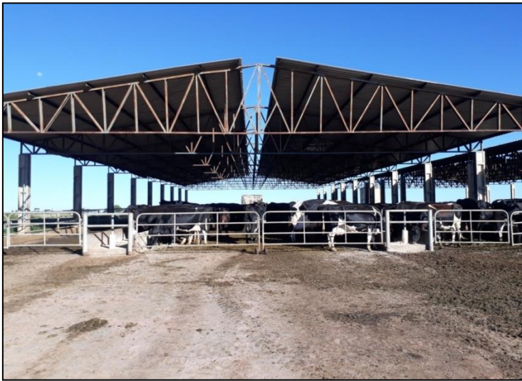
Figura 3 – Galpão de alimentação.
