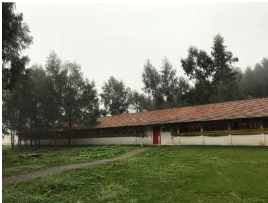
Figura 7: Galpão cobertura – área externa
