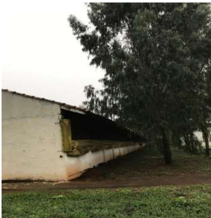
Figura 10: Galpão de gestação – área externa
