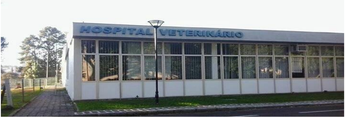
Figura 7. Vista frontal do Hospital Veterinário da Universidade Federal do Paraná – UFPR, Curitiba. Fonte: Arquivo pessoal.
